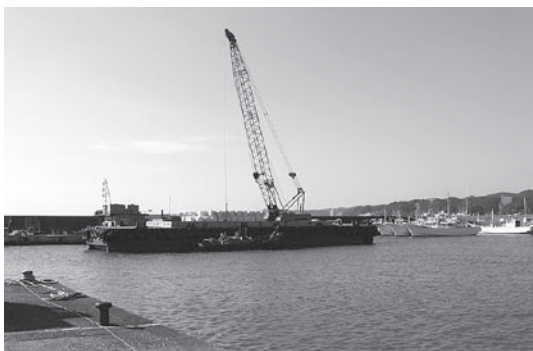
▶岩和田漁港の泊地浚渫工事
