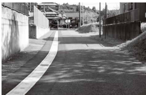
▲4001号線排水整備（布施小付近）
