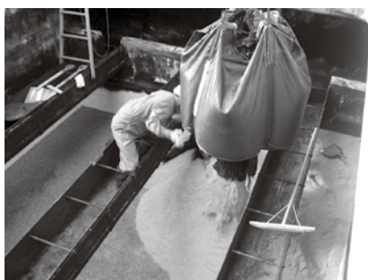
▲浄水場ろ過池ろ材更新工事実施状況
