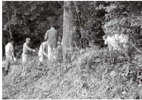
▲防護柵設置作業
