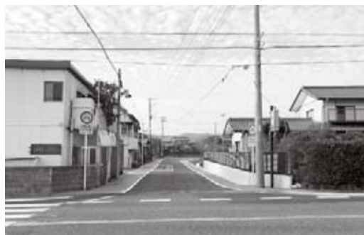
▲拡幅工事が完了した町道0202号線
