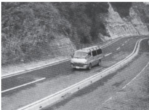
▲町道0109号線開通
