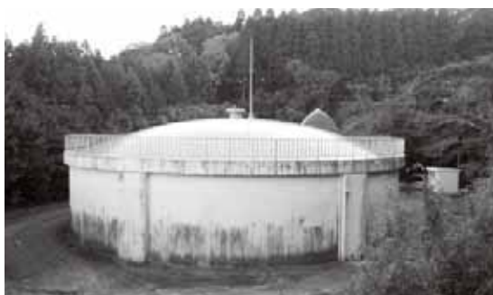
▲第一配水池屋根防水改修工事
