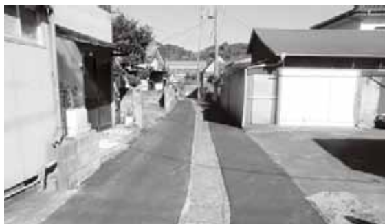
▲町道1054号線（岩和田区）舗装改良工事
