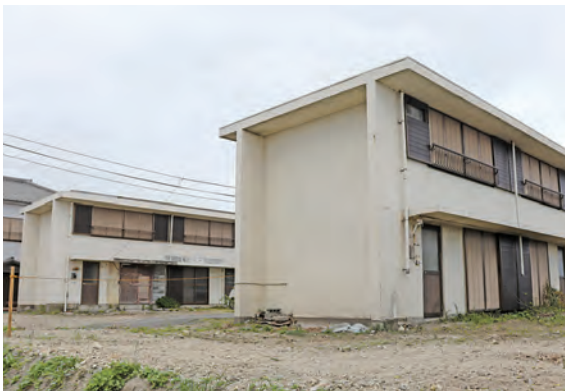
▲旧町営岩和田団地 令和2年度に倉庫、増築部分を解体しました。
