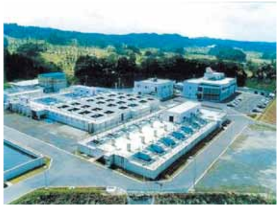
▲南房総広域水道企業団大多喜浄水場
