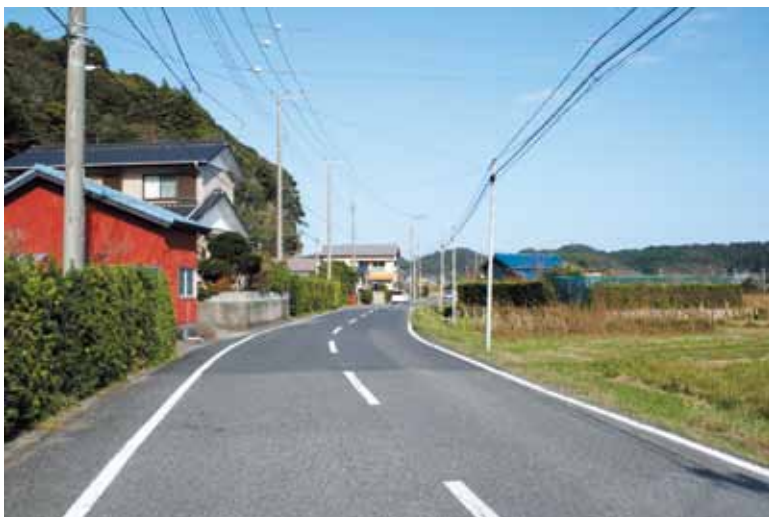
▲須賀・部田地先の町道0108号線
