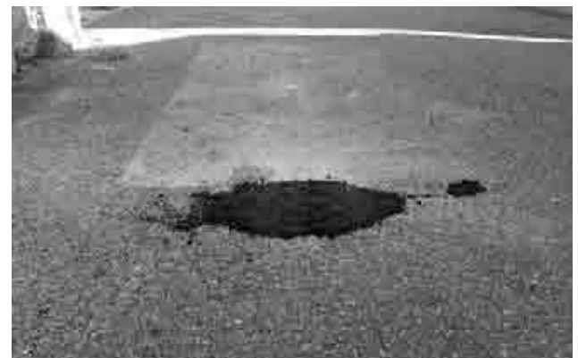
▲隊員から報告があった道路のくぼみを埋めて補修しました
