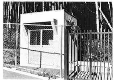
水圧を自動調整する施設
